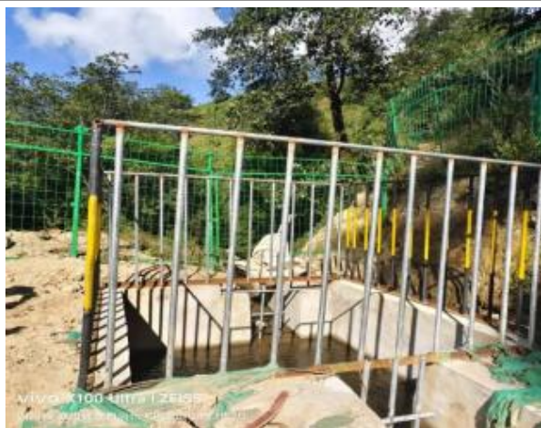
2325m 平台处沉淀池
