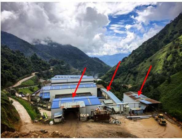
2 座封闭式破碎车间及皮带走廊
