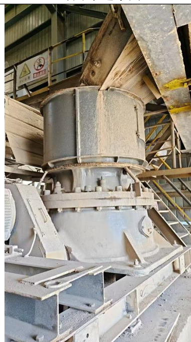
更换的圆锥破碎机照片
